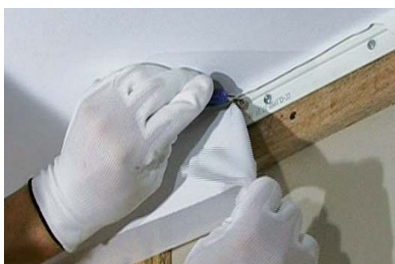
Обрезка покрытия
