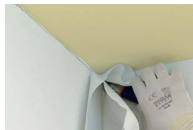
Удалить остатки покрытия из углов при помощи резака
