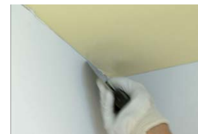
Заделать допуск покрытия в канавке профиля
